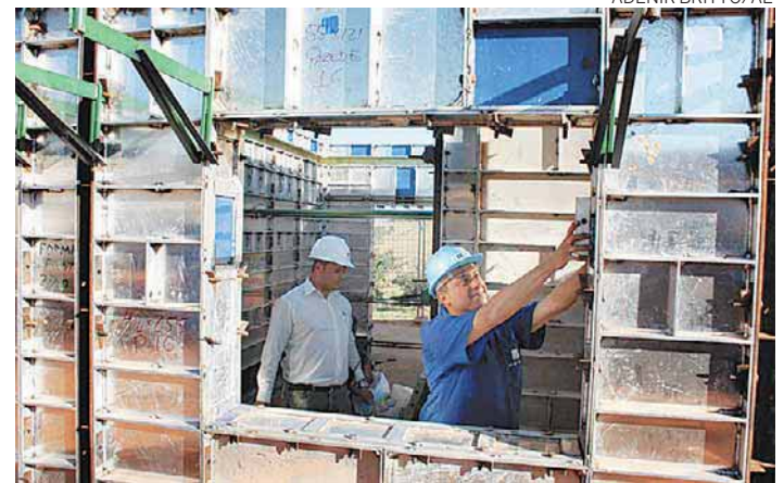
FÔRMAS - Sistemas usam fôrmas de aço, alumínio ou plástico
